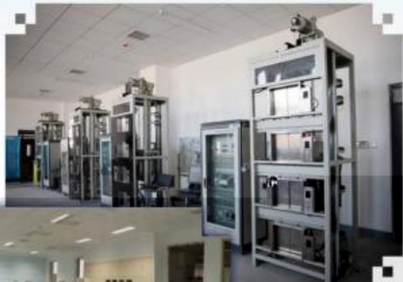
智能电梯安装调试 维护训练场所
